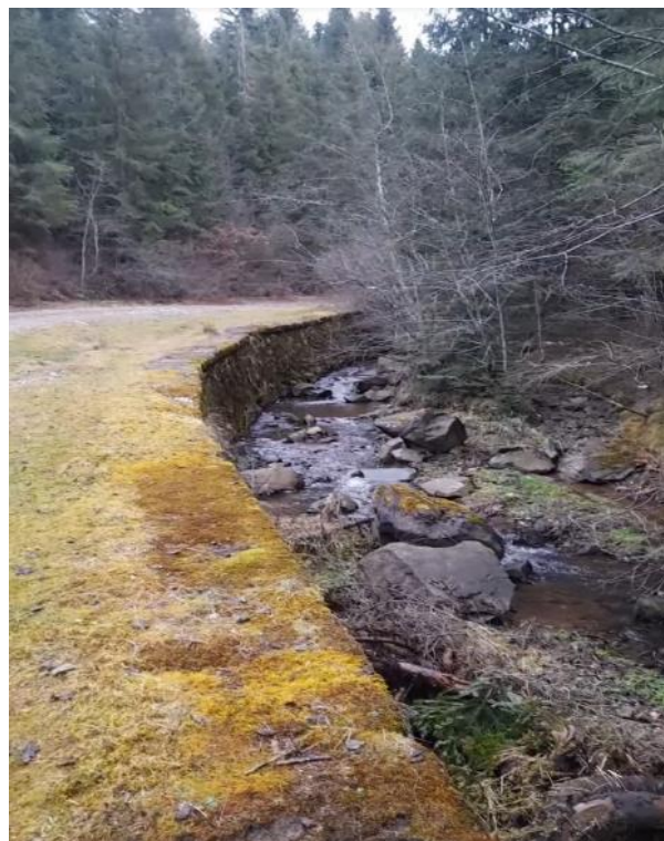
Călata în dreptul amplasamentului carierei vechi (zid de sprijin mal drept)
